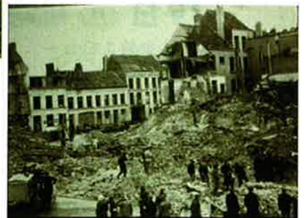
ロケット爆撃の被害現場
